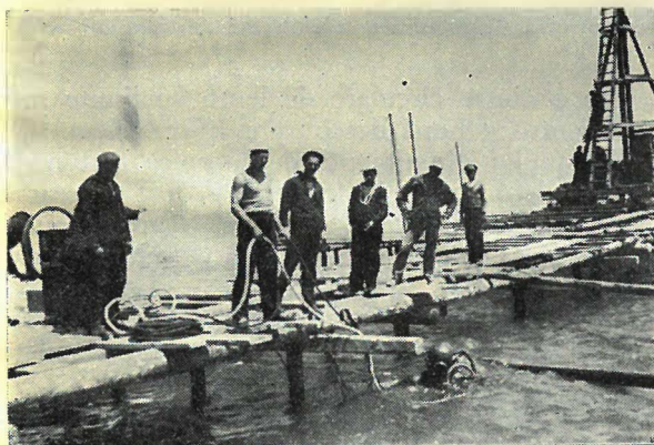
Fig. 7. — Așezarea plăcuțelor și ancorări de fierărie cu ajutorul scafandrierilor marinari
