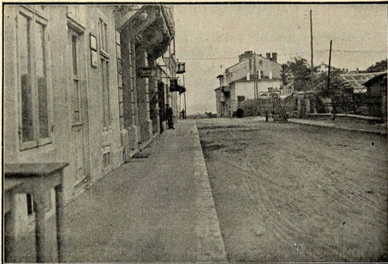
Trotuoare cu asfalt și partea carosabilă cu piatră de granit pe Str. Vasile Alexandri
